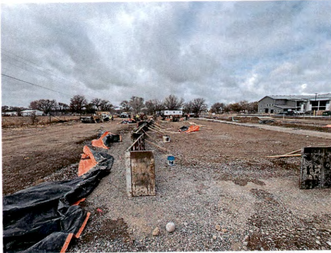
Setting for concrete pour
